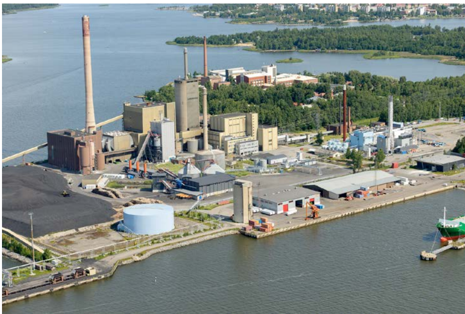
Kuva 2. Vaskiluodon voimalaitos Vaasassa. (Pohjolan Voima 2015.)
